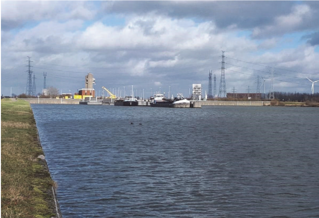
Figuur 34 Hoge en steile oever langs het kanaal. De sluis en deze verharde oever vormen een knelpunt voor otter.
