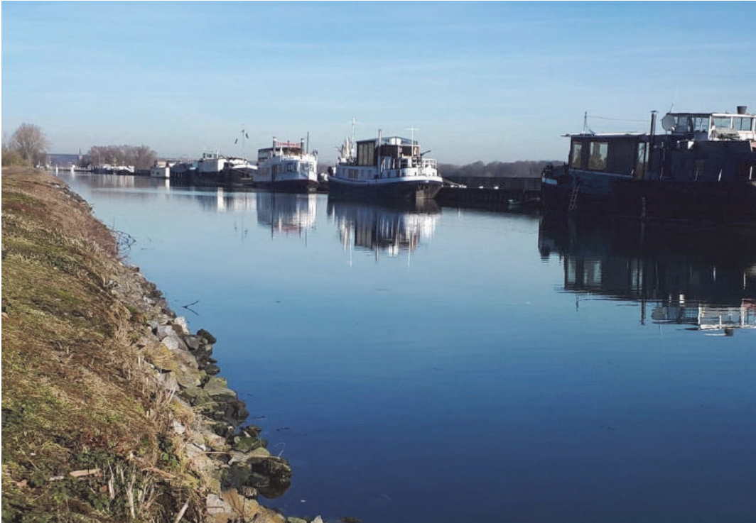
Figuur 61 Het kanaal is voorzien van verharde oevers. De oever links op de foto is opklimbaar voor otter, de oever aan de overkant vormt een knelpunt.
